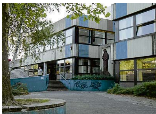
Das Schulzentrum an Holtwicker Straße, im Bild ist der Haupteingang zum Gymnasium Nepomucenum zu sehen, soll saniert werden. Foto: phk
